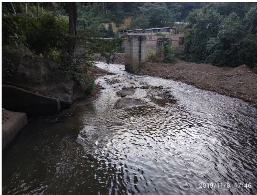
图 5.1-5 电站尾水排口情况
